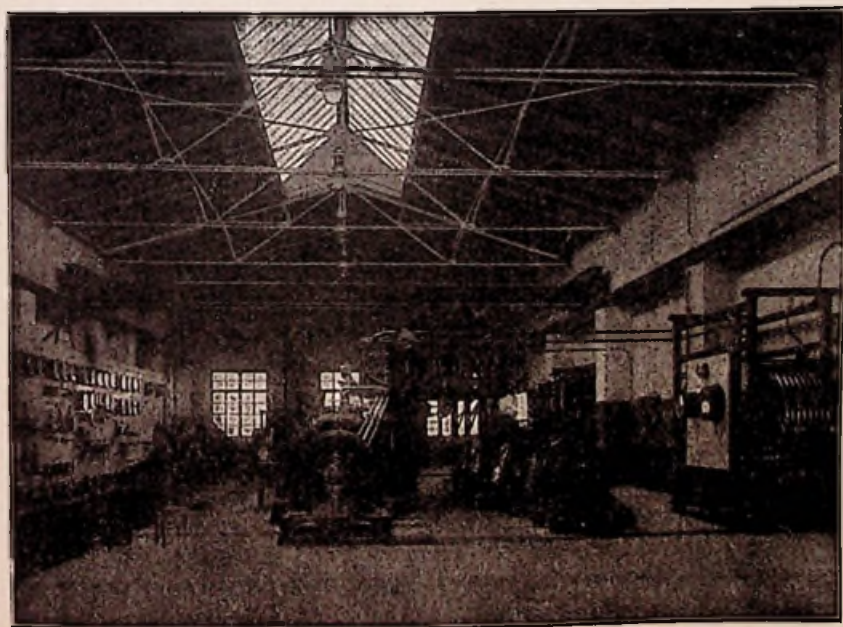
80. Zwei Goldschmidt-Hochfrequenzmaschinen nebst Antriebsmotoren in der Station Eilvese Über den Maschinen die Abstimmorgane
