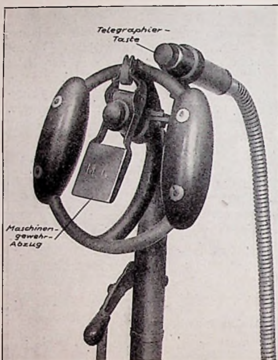
195. Steuergriff eines Jagdeinsitzers mit Funktelegraphie
