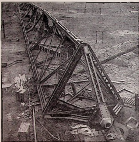
142. Ein gefällter Riese Der am 1. April 1912 vom Sturm umgeworfene 200 Meter hohe Antennenmast von Nauen. Im Vordergrund das Kugelgelenk
