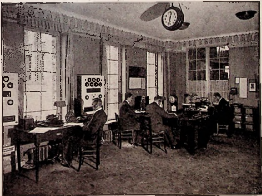
156. Telegrapherraum in Nauener Luftdrähte Vorn der Bedienungstisch für die Europa-Antenne mit Handtaste und Wheatstone-Schnellsender; dahinter der Bedienungstisch für die Übersee-Antenne
